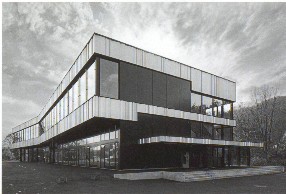
Westliche Stirnfassade mit Eingangsbereich
