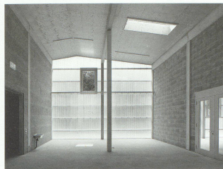
Halle local tempérée avec double peau en polycarbonate
