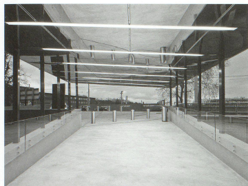
Vue depuis la marquise d'entrée vers l'Avenue de France
