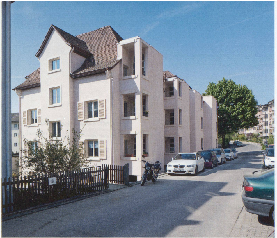
Neue Loggia-Anbauten als Erweiterungen von Küche und Bad
