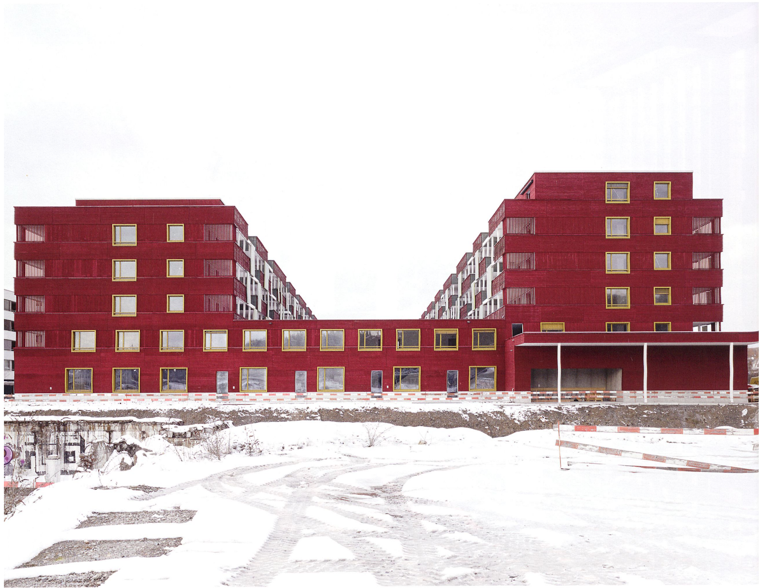
«Hybrid-Cluster» mit niedrigem Verbindungsbau. Ansicht von Süden
