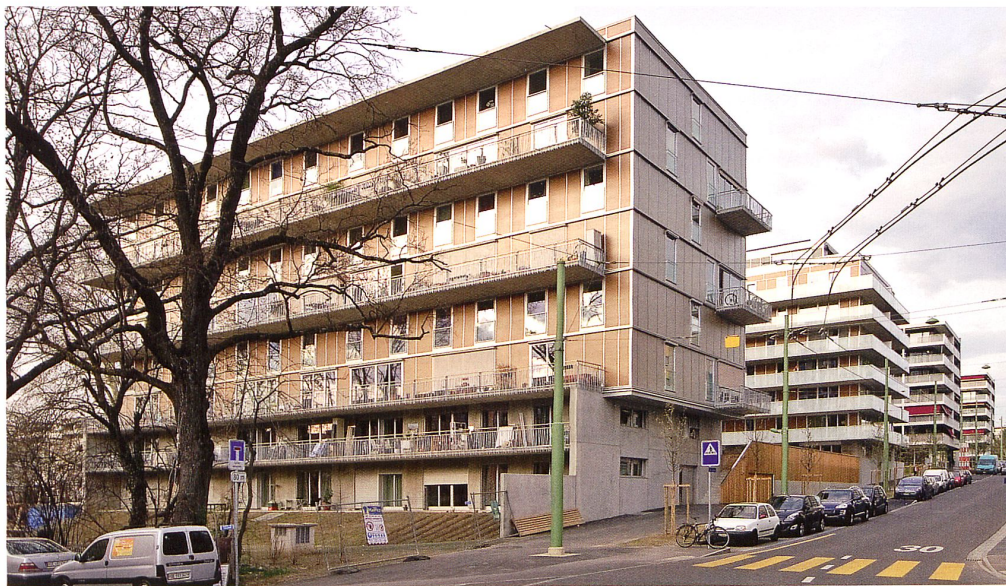
Der «Pommier» (im Vordergrund) ist Teil eines grösseren städtebaulichen Projekts
