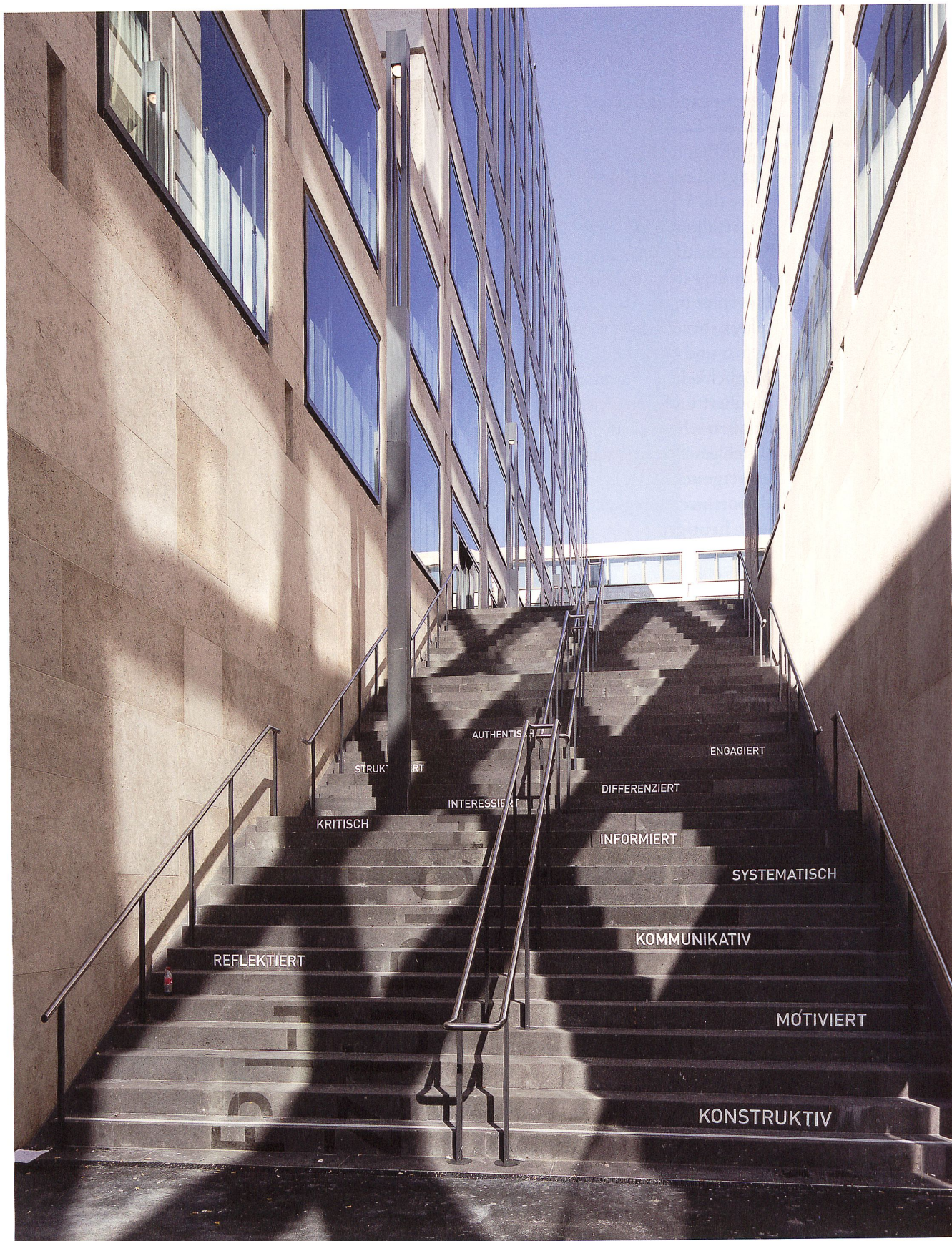
Die Treppe mit ihren 42 Stufen überwindet die sieben Meter Höhendifferenz zwischen dem Strassenniveau und der oberen Sockelebene. Bild: Dominique Meienberg
