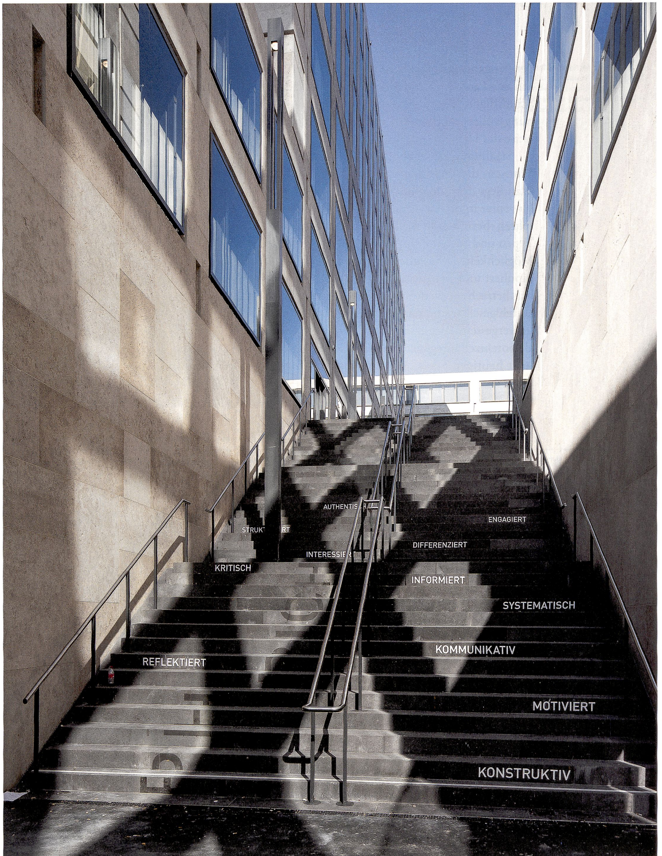
Die Treppe mit ihren 42 Stufen überwindet die sieben Meter Höhendifferenz zwischen dem Strassenniveau und der oberen Sockelebene. Bild: Dominique Meienberg
