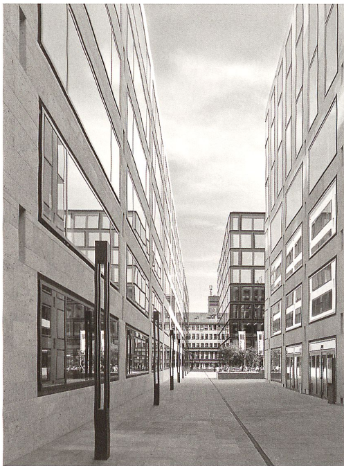
Schmale Gasse auf der Platzebene mit Blick auf das Hauptgebäude der Pädagogischen Hochschule, ganz hinten die Sihlpost.
