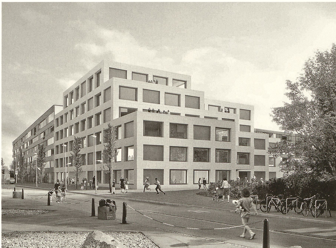
Das abgetreppte Volumen schafft eine eigenständige Bauskulptur mit einer Terrassenlandschaft, die zugleich als Fluchtweg dient.
