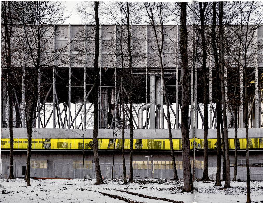
Maschine im Wald: Der Baukörper der Energiezentrale liegt in einer gerodeten Lichtung. Fassade und Konstruktion der Grossform sind in ein modulares System von Betonelementen aufgelöst.
