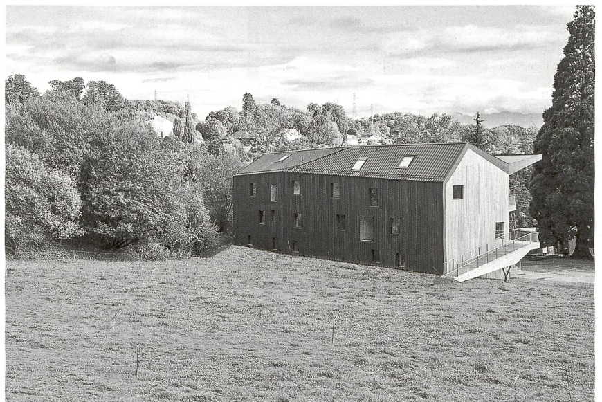
Vue de la façade sud, avec ses coursives extérieures distribuant les salles de classes (en haut); L'enveloppe périphérique est en mélèze naturel sur les pignons et teinté à l'arrière.
