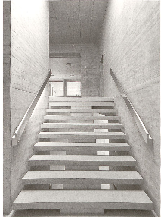
Treppe zum 2. Obergeschoss
