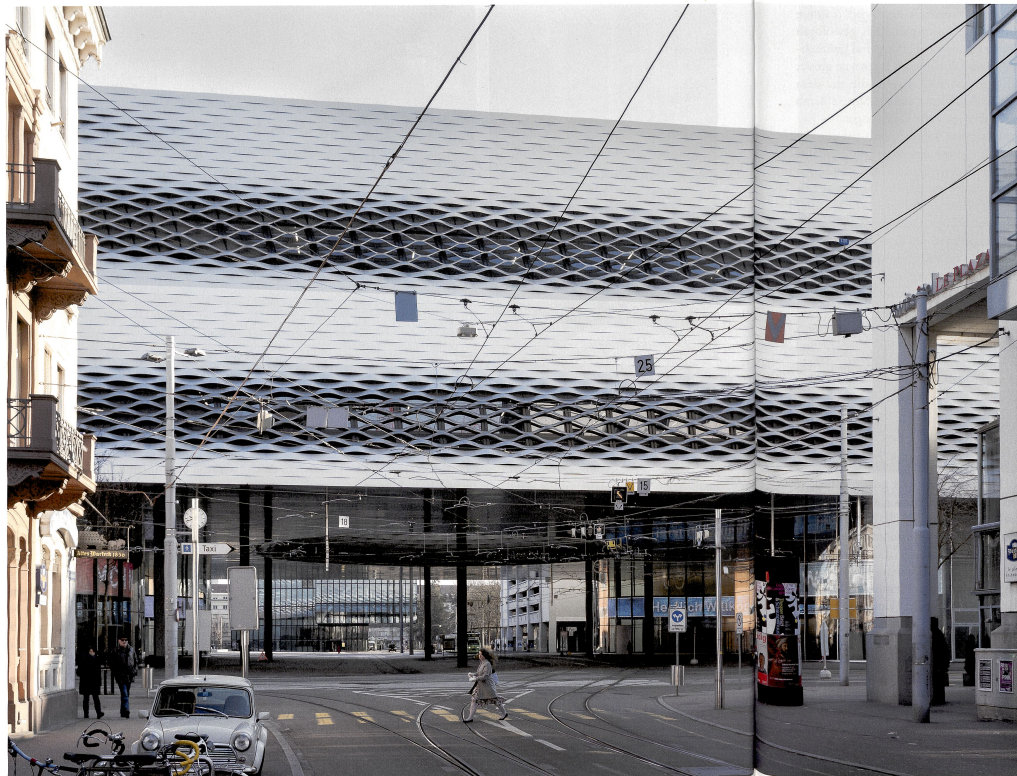
Blick aus der Clarastrasse auf die neuen Hallen und den überbauten Messeplatz. Im Hintergrund der Fuss des Messeturms. Die Fassade aus 15 000 Aluminiumblechern öffnet sich an ausgewählten Stellen und stellt den Bezug zum menschlichen Massstab her.
