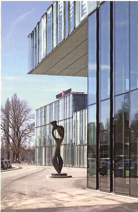
Kunstwerke aus der Sammlung Würth schmücken den neuen Firmensitz und werden in einer eigenen Ausstellungshalle präsentiert. Bild: Thies Wachter
