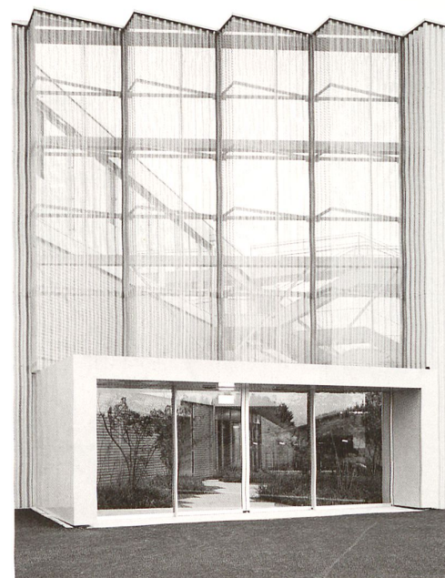
Homogene Hülle: Gelochte Aluminiumbleche umgebenden ganzen Baukörper (oben) Eingang zum «inneren Garten» zwischen Büro- und Hallenbau.
