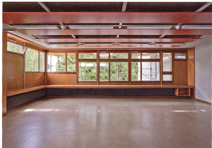
Die hölzernen Fensterwände in den Klassenzimmern blieben unverändert bestehen; nur Isolierverglasung und Lüftungsautomatik sind neu.
