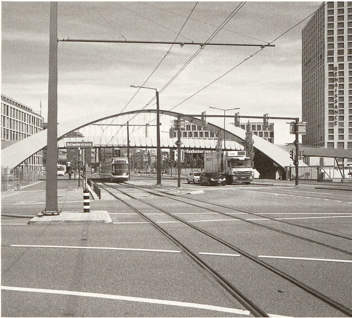
In der Pfingstweidstrasse in Zürich verkehrt das Tram auf Eigentrassee und hat eine massive Verbreiterung dieser Ausfallstrasse ausgelöst, Zäune sperren den Gleisraum ab. Bild: Andrea Helbling.
