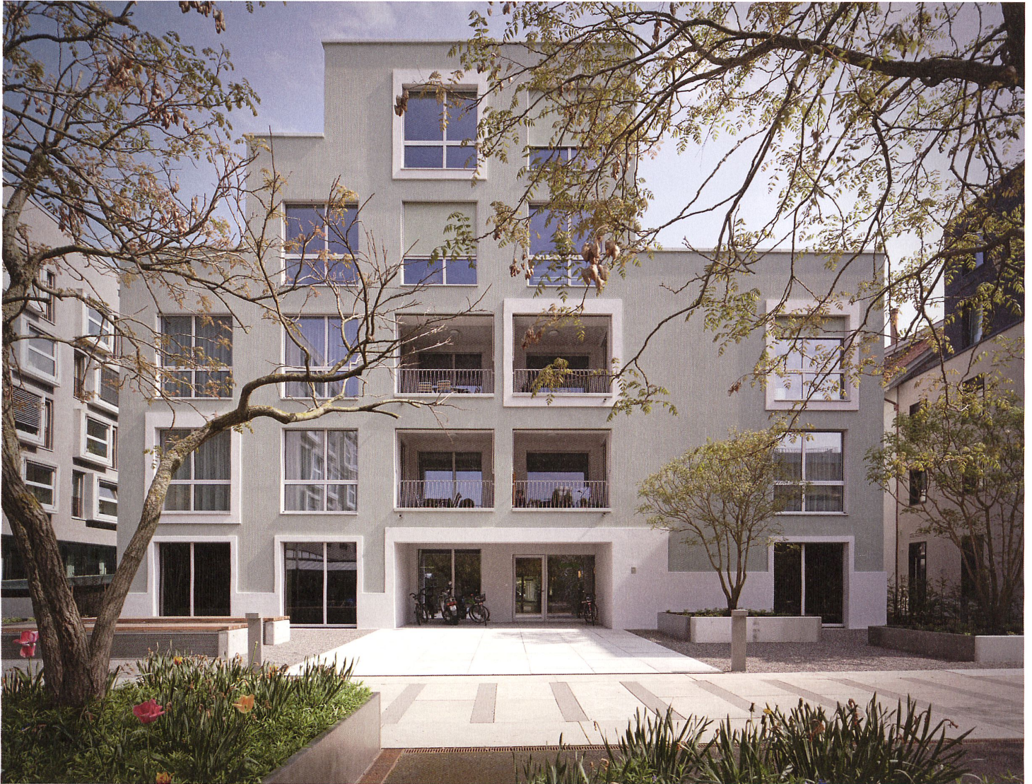
Hauptansicht am Neustadtplatz. Leicht asymmetrisch geteilte Fenster und frei gesetzte Rahmungen verfremden das Bild der umgebauten Schule.
