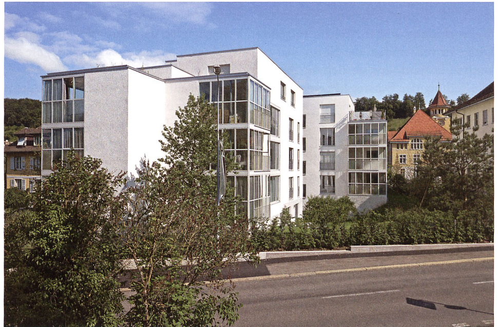
Ansicht von Süden: Die zahlreichen Versprünge des Volumens unterstützen die Integration des Neubaus in das kleinteilige Quartier.
