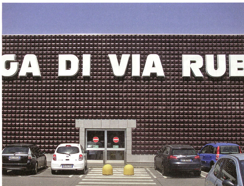
Fassade des Supermarkts Esselunga an der Via Rubattino in Mailand mit vorfabrizierten Zementkissen, genannt «Bugnato». Dieses Rustica-Element ist von Caccia entworfen und veredelt manchen Gewerbebau. Bild: Astrid Stauer
