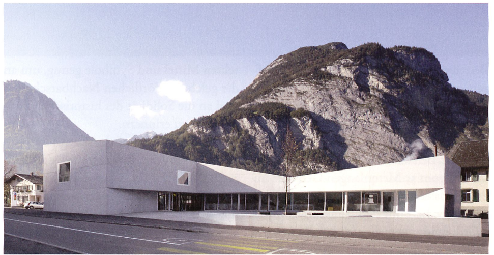
Freistehender Zentrumsbau in Innertkirchen Bild: Tom Bisig
