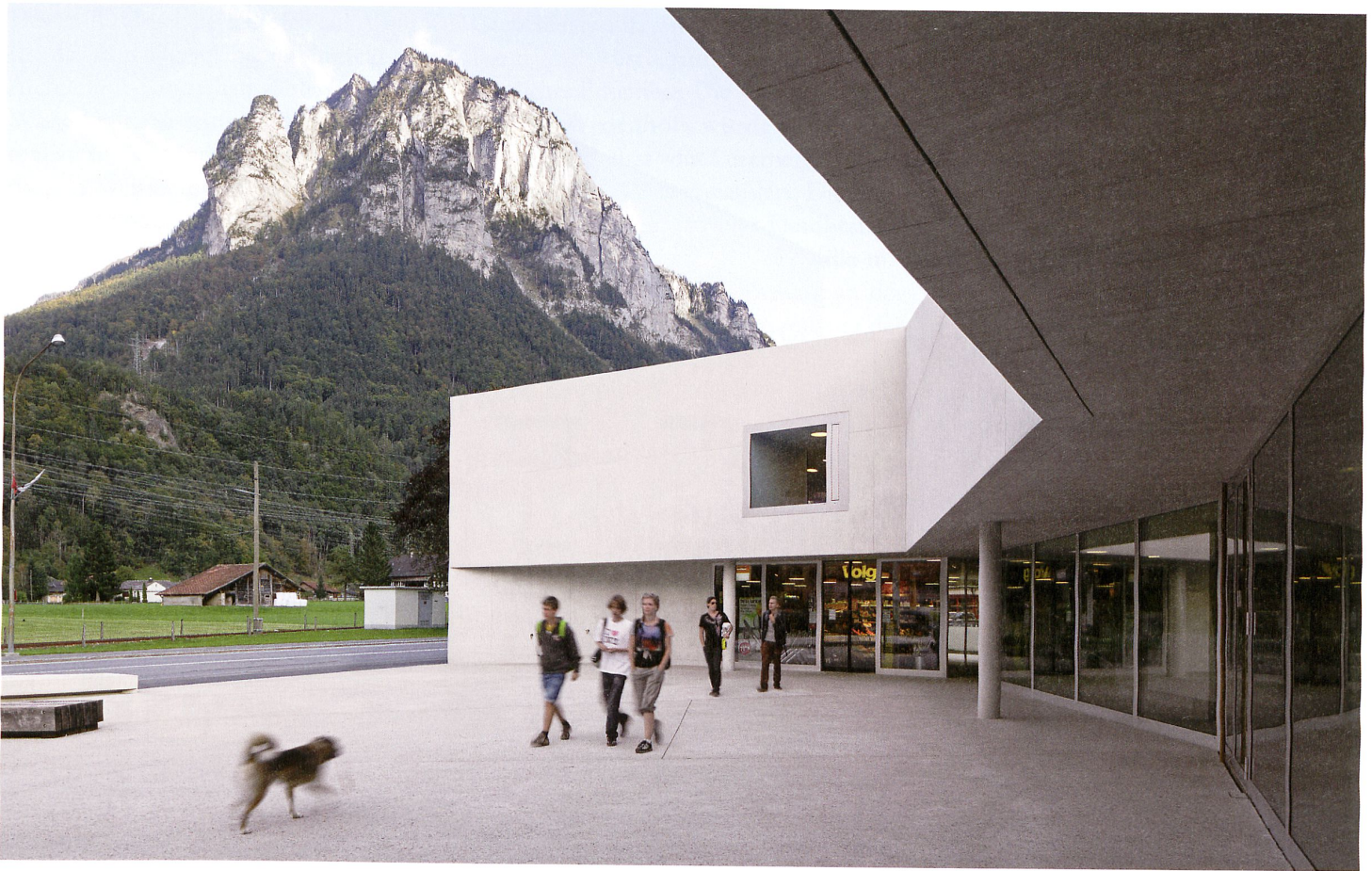
Innertkirchen: Das niedrige Gebäude umfasst mit seiner konkaven Fassade einen öffentlichen Vorplatz. Bild: Tom Bisig
