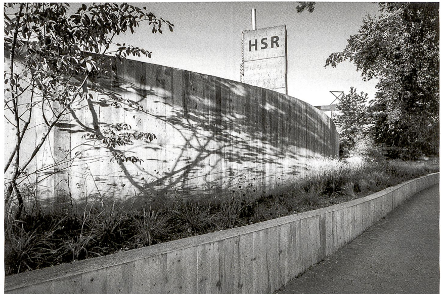
Die Wertstoffsammelstelle vermittelt als landschaftlich gedachte Architektur zwischen Campus und Strasse. Bilder: Stefan Bienz
