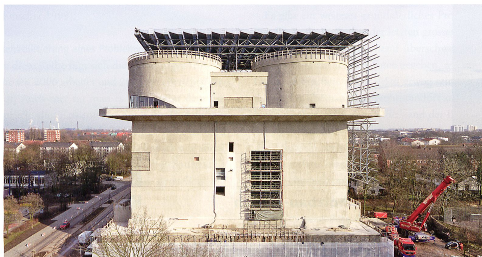
Der «Energiebunker» – ein Flak-Bunker aus dem zweiten Weltkrieg – umgebaut zum Wärmespeicher für das Quartier
