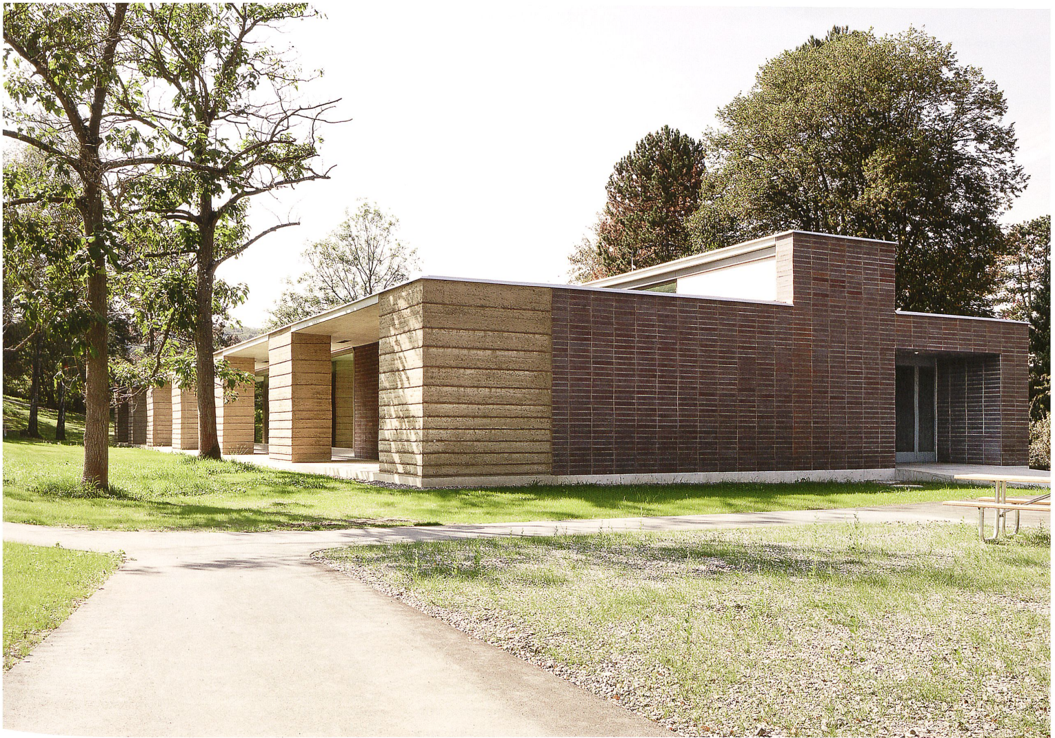
Massivität in Lehm: gestampft bei den Wandstücken vor der Veranda (links), als Verkleidung an der Stirnfassade
