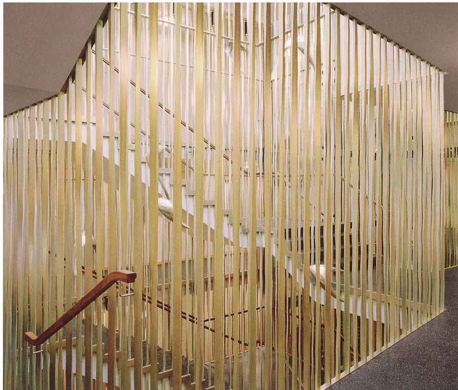
Metallenes Stabwerk im zentralen Erschliessungsraum
