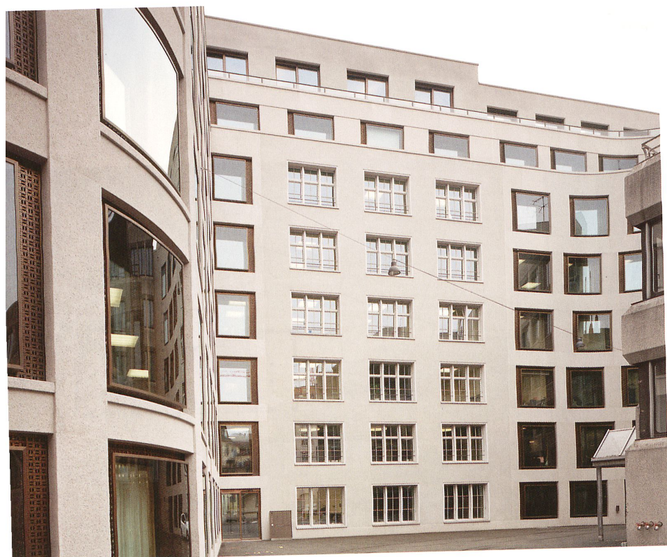
Hoffassaden von Alt- und Neubaufüügeln, im Winkel der hindernisfreie Eingang.
