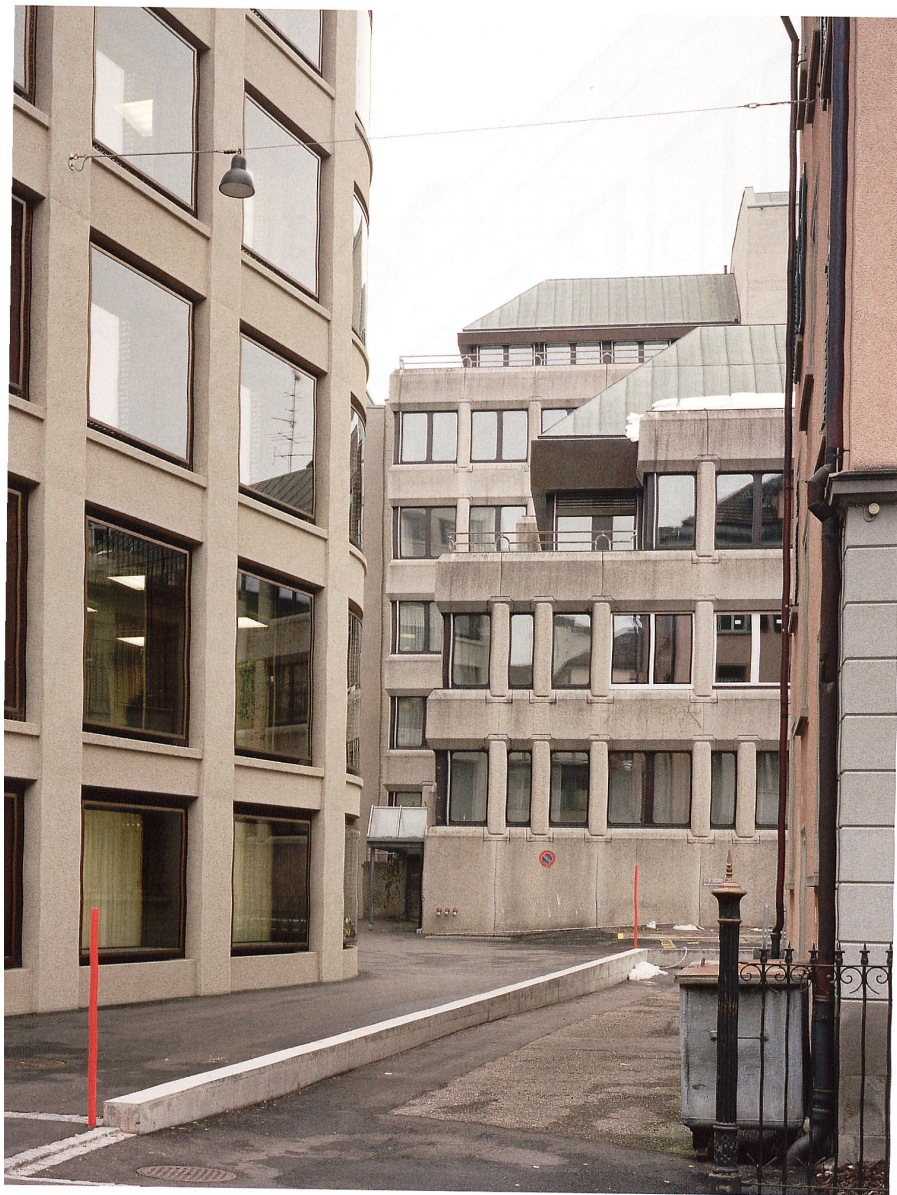
Die Hoffassaden sind gleichwertig zur Vorderfront gestaltet.
