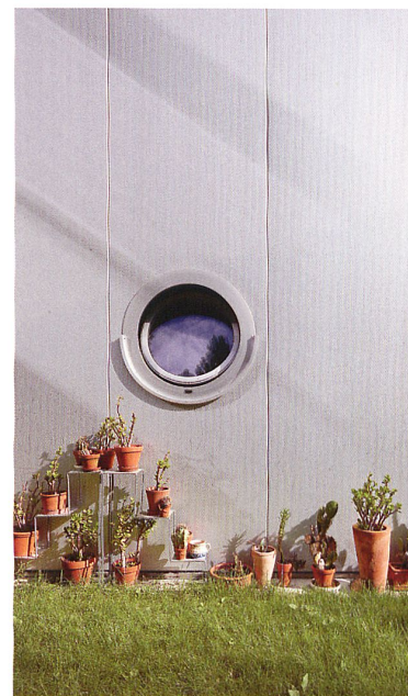
In die industriell gefertigten Paneele lassen sich problemlos auch runde Fenster schneiden.
