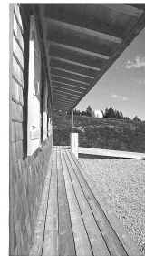
Vorhalle des Pavillons
