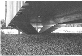
Zwei V-Säulen tragen die Beobachtungsplattform
