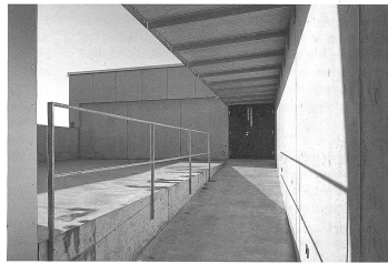
Offener Hof mit Blick Richtung Plattform
