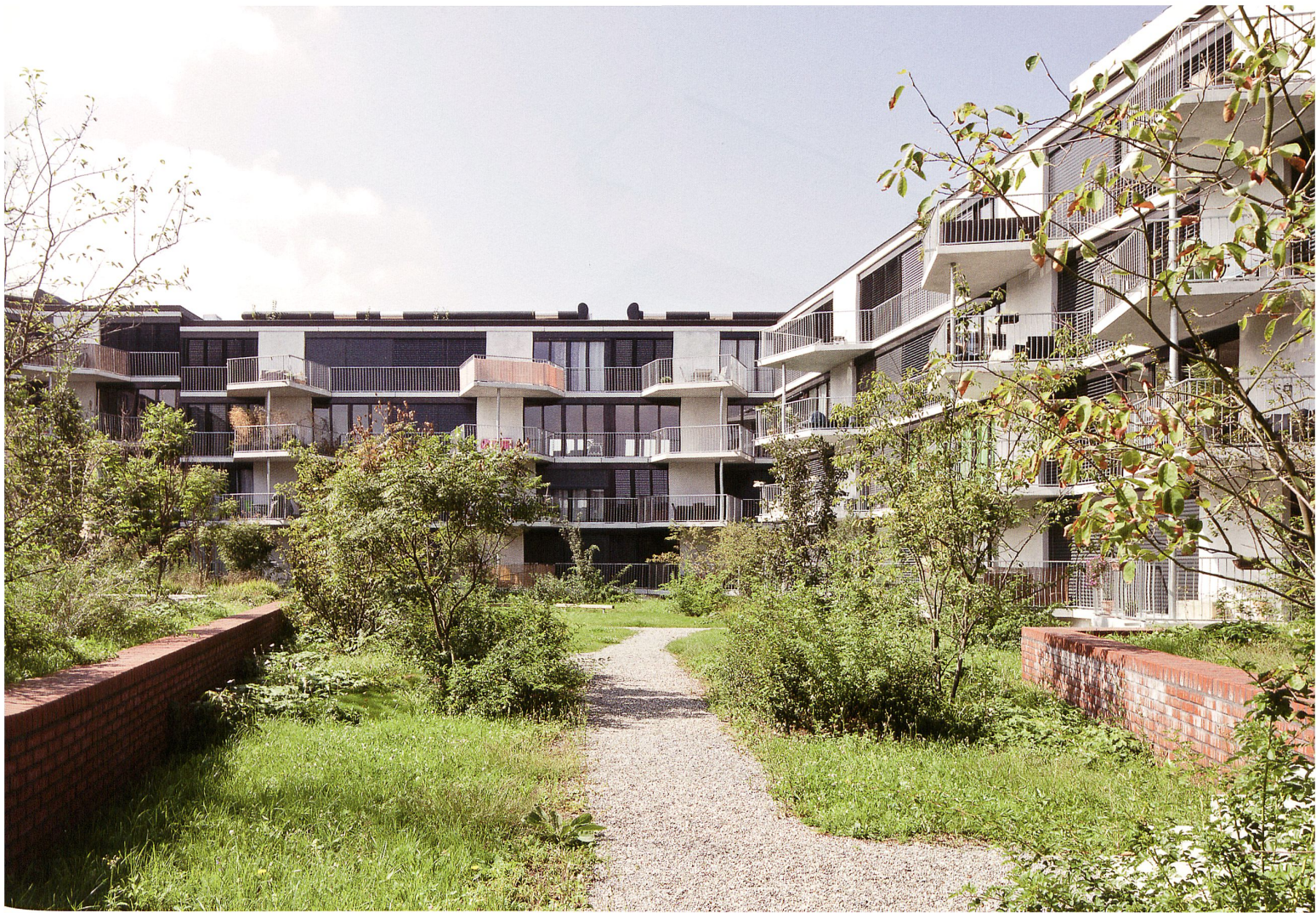
Garten auf dem Dach
