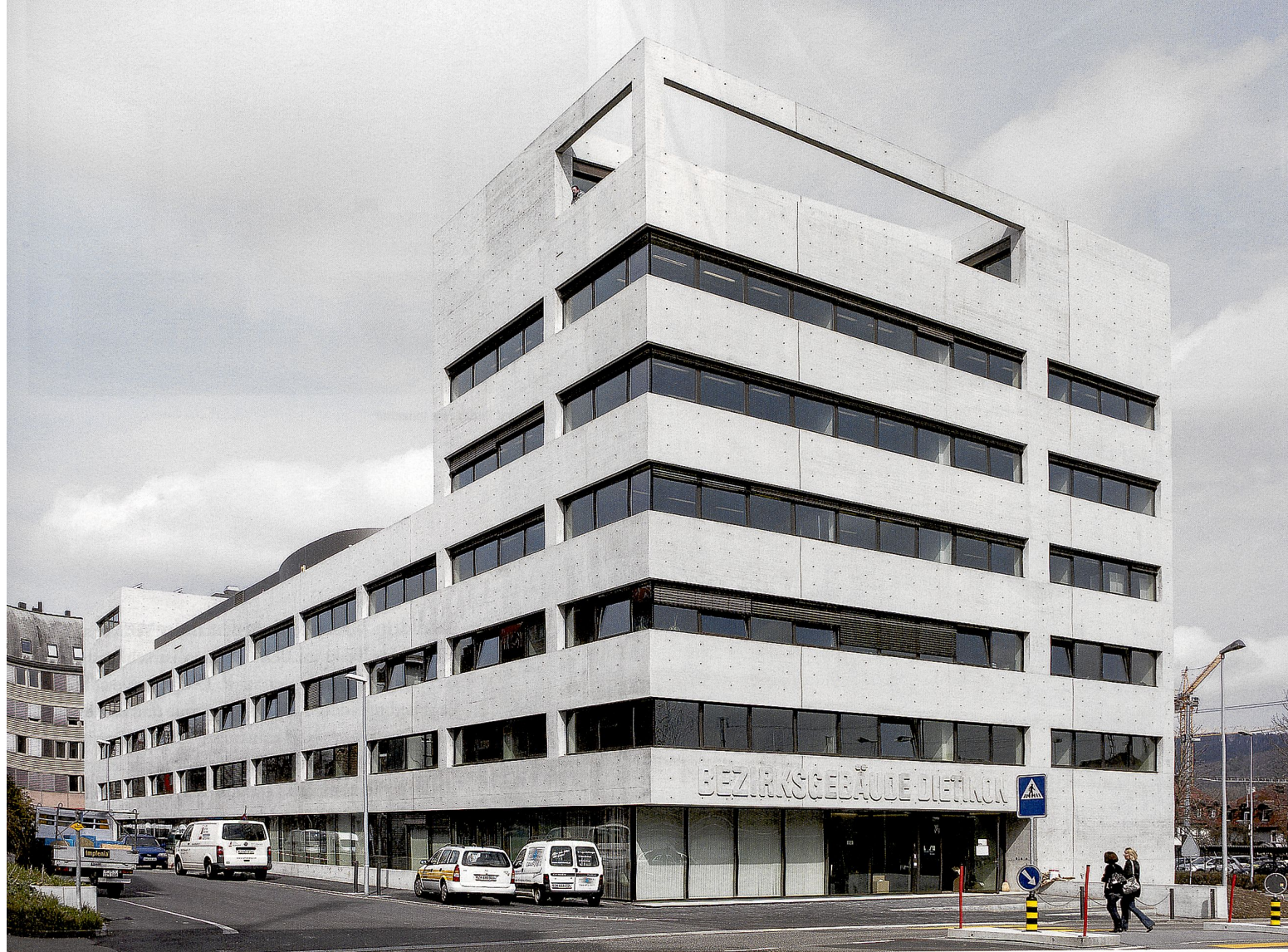
Zum Bahnhofplatz markiert ein siebengeschossiger Kopfbau Präsenz.
