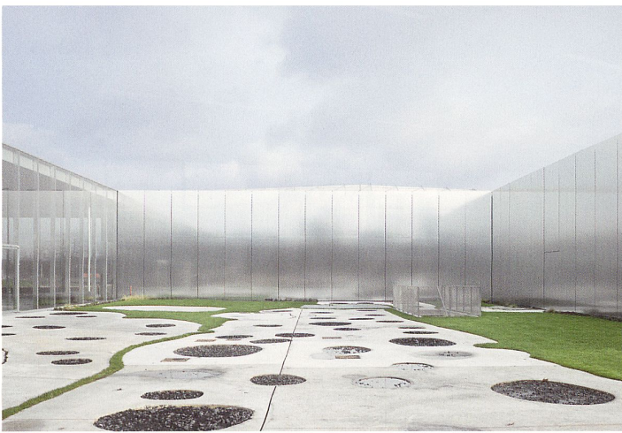
Mélange aus Dimension, Diskretion und Diffusion: Fassade mit Glas- und Aluminiumpaneelen
