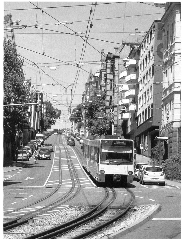
Stadtbahn Stuttgart in beengten Strassenverhältnissen. Trotz grundsätzlichem Eigentrassee die kann die Stadtbahn abschnittsweise auch im Mischverkehr geführt und damit flexibel in den Stadtraum integriert werden.
