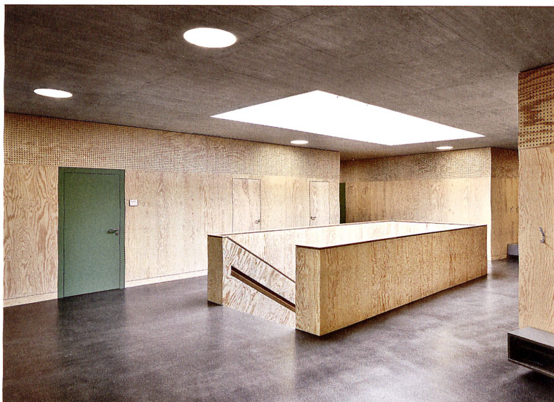
Kindergarten in Aadorf: Der Baukörper mit dem feinen Relief ist innen mit geöltem Seekiefer-Sperrholz ausgeschlagen. Fluchtwege direkt ins Freie erlauben die Bespielung der Erschliessungszone. Bilder: José Hevia
