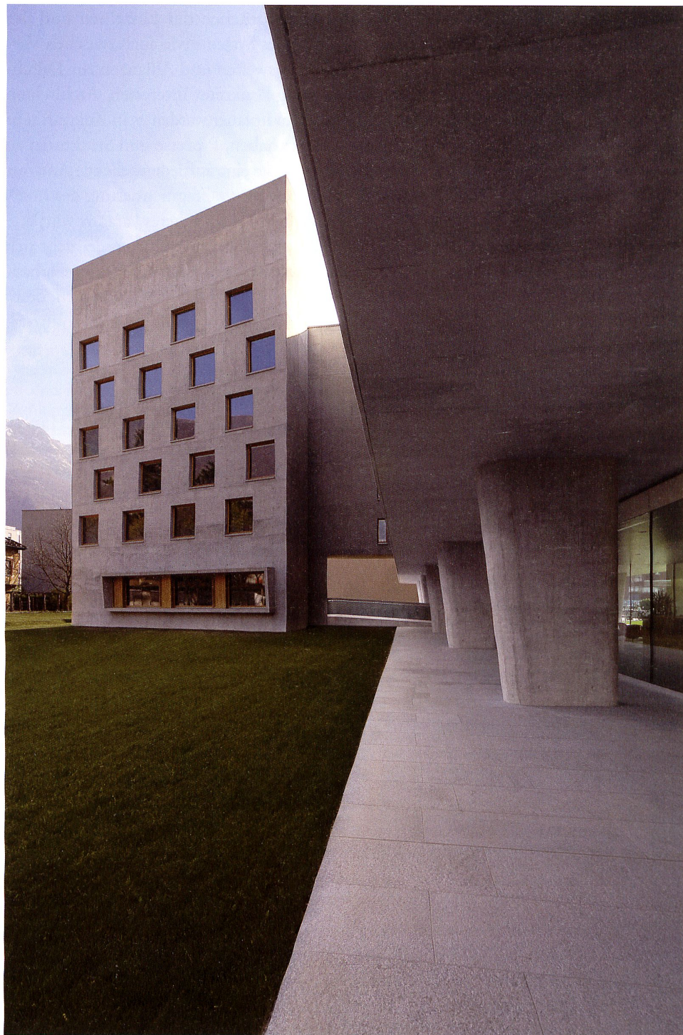
Pilotis, offenes Erdgeschoss und Turm: Luigi Snozzi, Mitbegründer der «Tendenza», führt mit seiner Tochter und deren Ehe- mann moderne Architektur und Geschichte zusammen.
