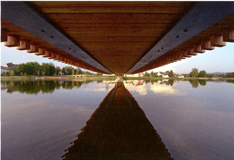
Die schlichte und innovative Max-Gleissner-Brücke in Tirschenreuth spannt über den historischen Stadtteich. Lärchenbohlen liegen auf zwei dünnen Stahlbändern.
