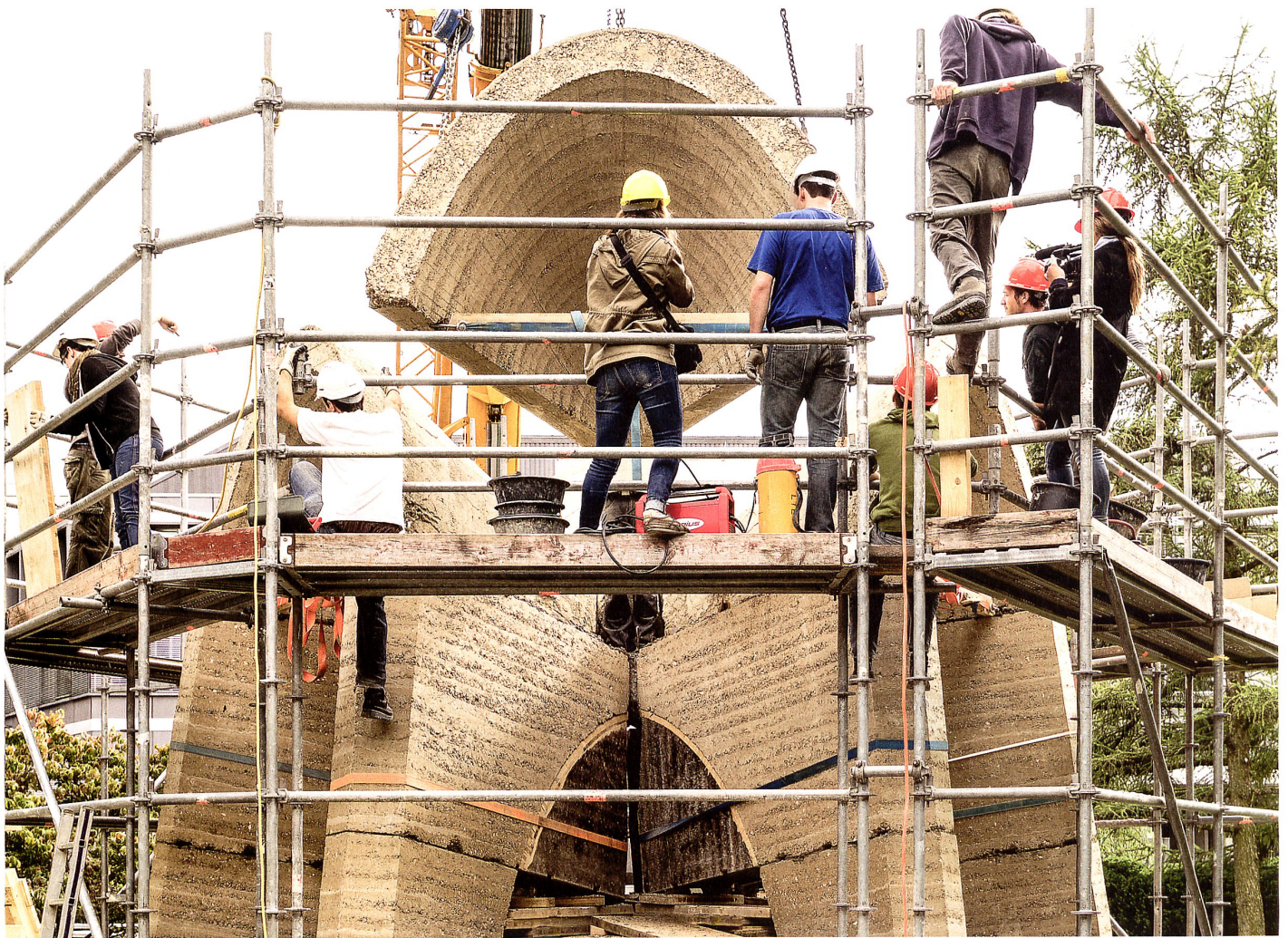
An der Professur für Architektur und Konstruktion von Annette Spiro der ETH Zürich haben Studierende unter der Leitung von Gian Salis den Zusammenhang von Material und architektonischem Ausdruck untersucht. Dabei konnten in Zusammenarbeit mit Martin Rauch und Andreas Galmarini erstmals tragende Gewölbe aus Stampflehm gebaut werden. Bild: Gian Salis
