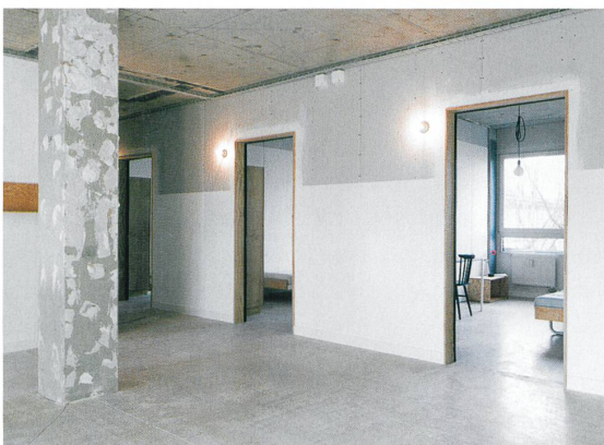
Der Korridor als Lesesaal – und Blick in die möblierten Zimmer im 2. Obergeschoss von Haus B.
