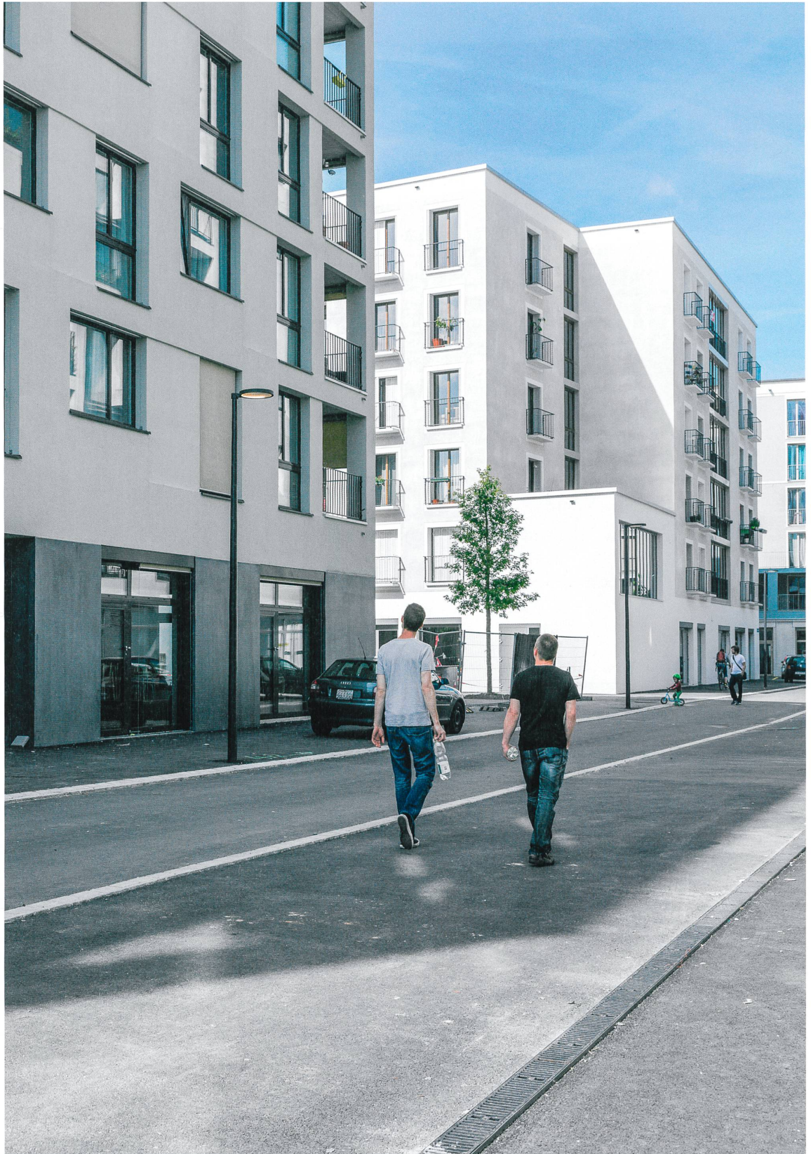
Strassenraum vor den Häusern H (links) und A
