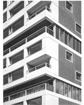
Die Fassaden sind elementar gegliedert und repräsentieren die verborgene Platten-Scheiben-Tragstruktur, aus der auch die Teilierung des Körpers hervorgeht.
