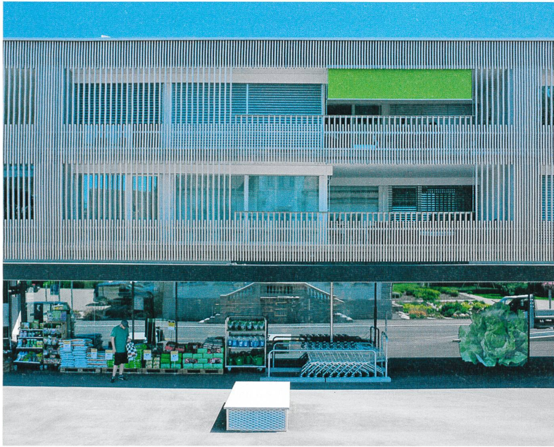
Das auskragende Vordach und ein Stabwerk aus kanadischer Zeder schützen die Privatheit der Wohnungen. Bild: Manfred Schafer
