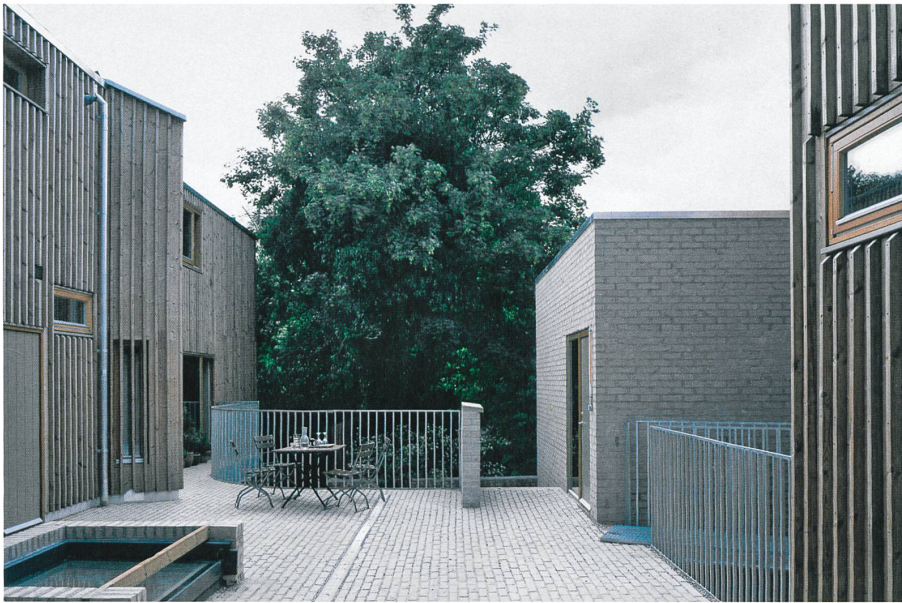
Die Differenzierung halbautonomer Häuser über das Material – und erst recht mit Holz! – ist im Land der kleinen, normierten Backsteinhäuser eine selten gesehene Fertigkeit von Architekten. Bild: Ioana Marinescu
