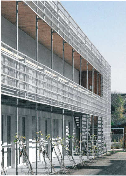
Die Fassade ist Rankgerüst für Kletterpflanzen. Bilder: Stefan Müller-Naumann
