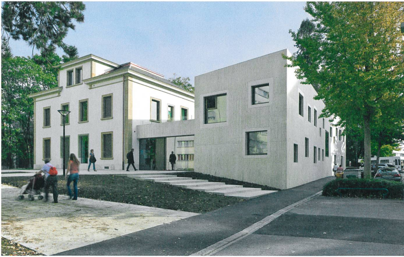
Der Neubau der Krippe ordnet sich der bestehenden Villa unter. Bilder: Thomas Jantscher
