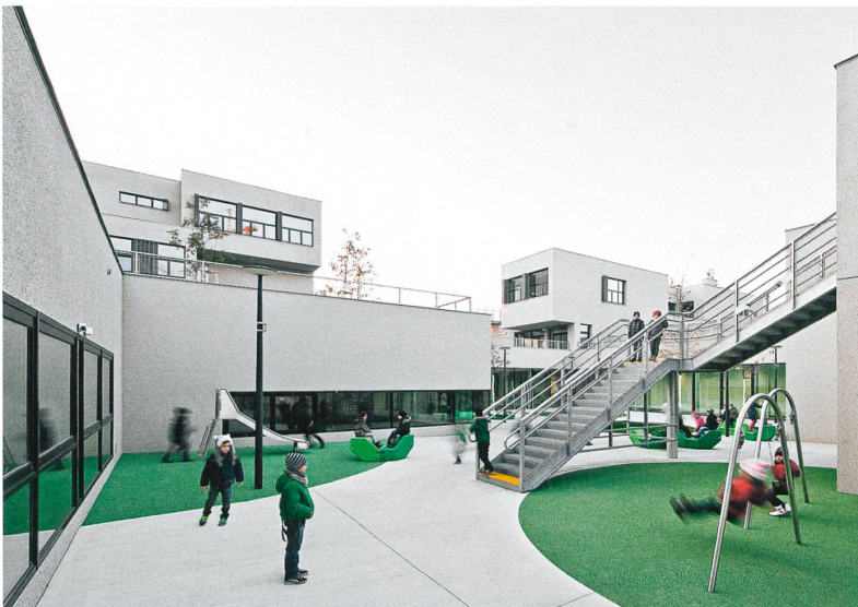
Über aussenliegende Treppen sind die umliegenden Freiflächen auch aus dem Obergeschoss direkt erreichbar.
