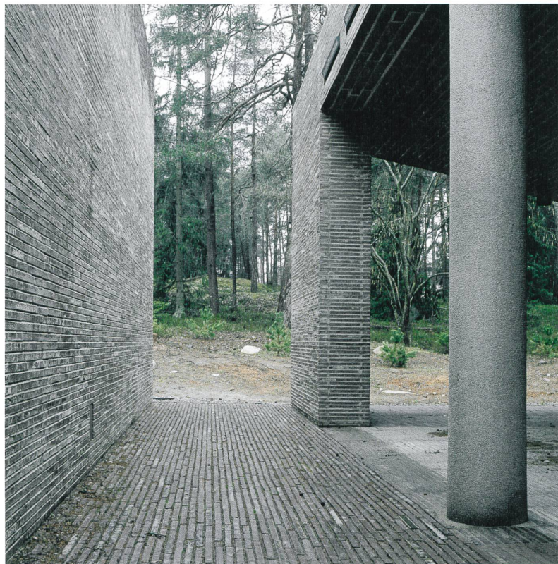
Das Krematorium duckt sich zwischen die Wipfel des bestehenden Föhrenwaldes. Ein tiefer Einschnitt trennt die Eingangshalle vom steinernen Bau. Bilder: Ioana Marinescu
