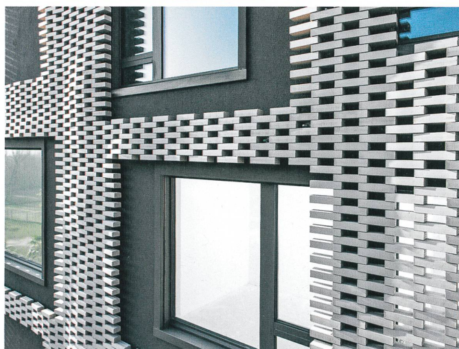
Die Körper der drei Wohnhäuser sind nahtlos mit Elementen aus vom Roboter gefügten Ziegeln bekleidet. Bilder: Nicola Walbeck
