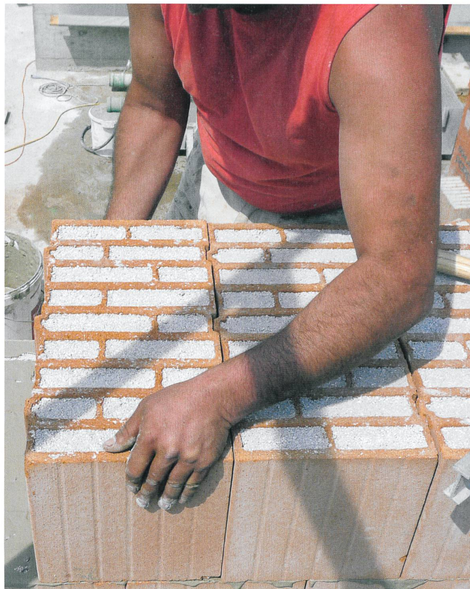
Die Baustelle lässt den Cluster-Grundriss mit Satellitenwohnungen und den versteifenden Kern in der Mitte erkennen (Bild oben: Johannes Marfurt). Quer versetztes Einsteinsmauerwerk mit Perlitfüllung (Bild: Katinka Cortis)
