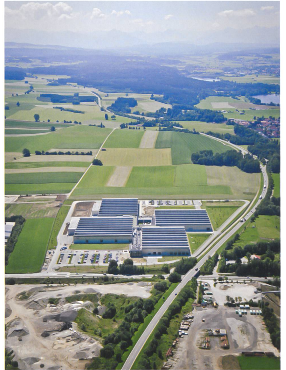
Neben den Reserven innerhalb der Fabrik hält die grüne Wiese noch grosszügige Erweiterungsflächen bereit. Die Flexibilität ist ein kategorischer Imperativ des Industriebaus. Bild: Ina Reinecke
