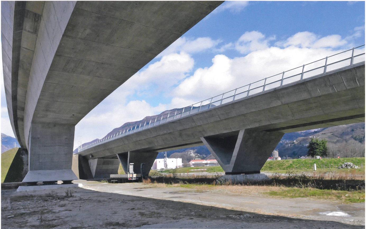
Der Doppelviadukt von Camorino am Nordportal des Ceneri-Tunnels vermeidet ein Zerschneiden des Talbodens. V-Stützen nehmen die horizontalen Bremskräfte auf.
