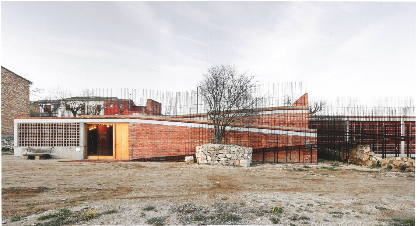
Mittel des modernen ländlichen Zweckbaus: industrieller Backstein, Betonskelett und frei herausragende Armierungs Eisen fügen sich zu einem geheimnisvollen Ort am Rand des katalanischen Dorfs Seró.
