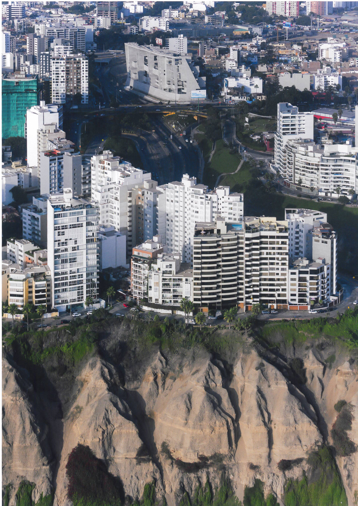
Das neue Universitätsgebäude (oben in der Mitte) steht in einer coupierten Topografie und vermittelt zwischen zwei städtebaulich sehr unterschiedlichen Quartieren. Bild: Iwan Baan
