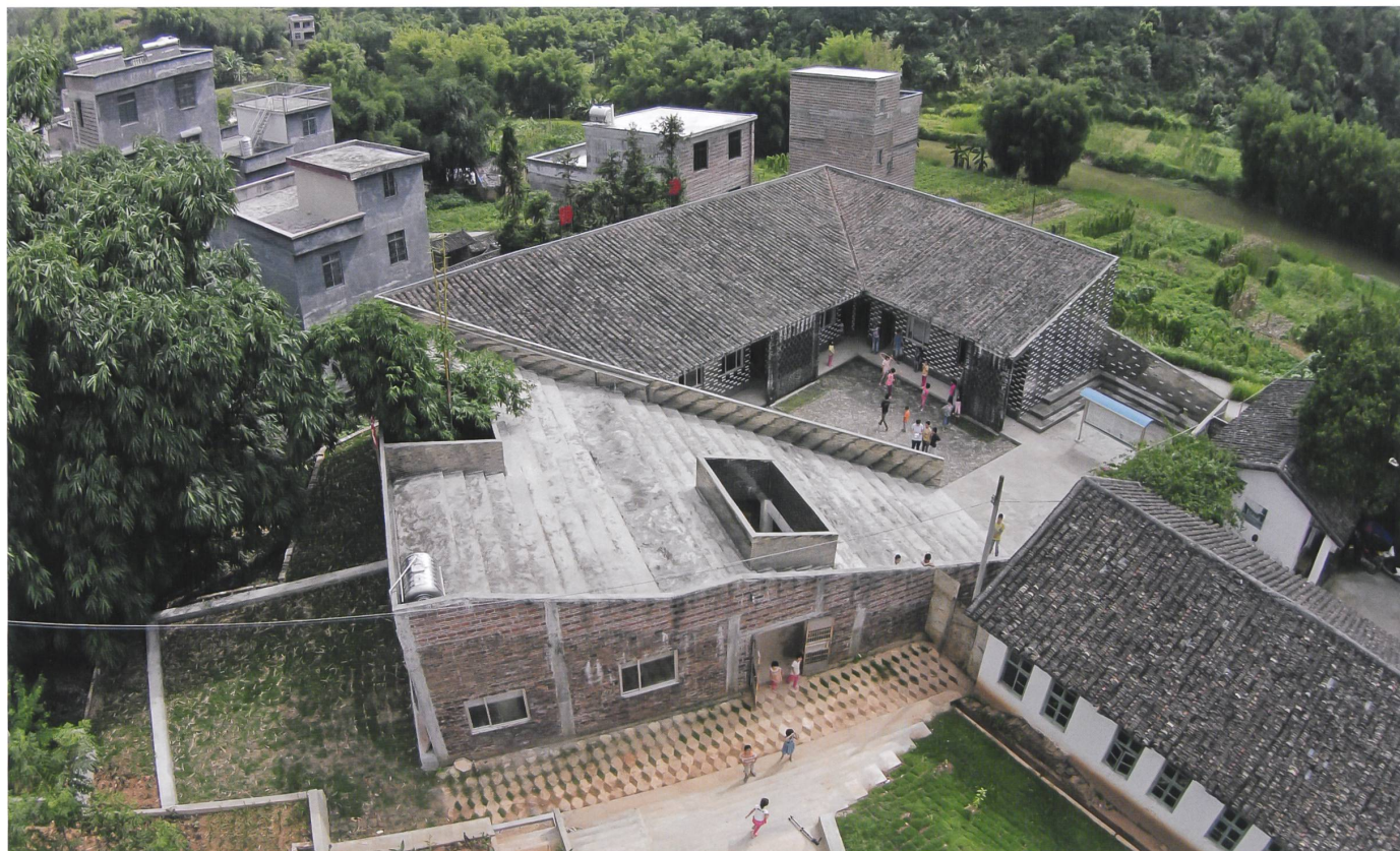
Schule Mulan: Der Neubau besteht aus Recyclingbacksteinen und -Dachziegeln. Die Anlage ist ein öffentlich zugänglicher Treffpunkt im Dorf.
