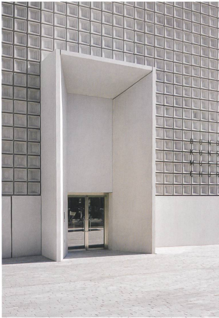
Der monumentale Eingang macht in Chur die Erweiterung des Kunstmuseums zum Hauptbau. → S. 71 Bild: Simon Menges
