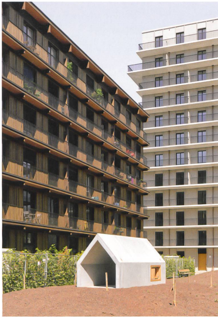
Elementbau in Holz und in Beton begegnen sich in Rolf Mühlethalers Wohnbauten im Freilager Zürich. → S. 8 Bild: Alexander Gempeler
